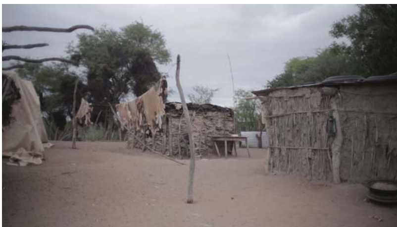
FIGURA 5. Habitaciones edificadas en quincha. Atrás: palo y barro; adelante: caña y barro. Foto del equipo de producción del documental Nómadas (octubre de 2016).
